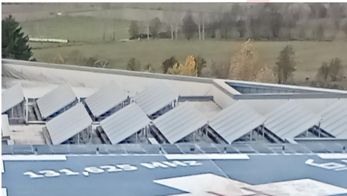
Módulos Termo-solar para producción de ACS
