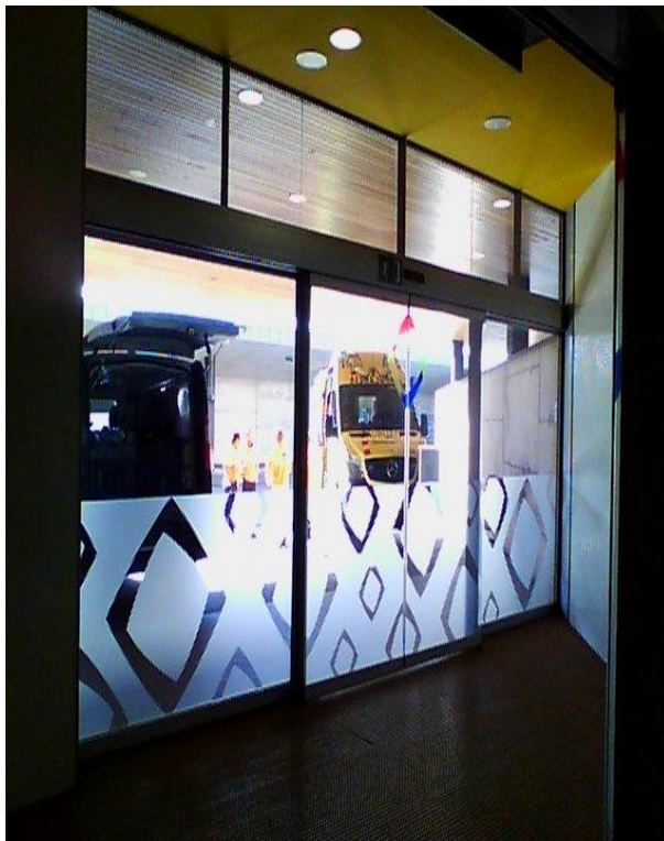
-Puerta interna de acceso Emergencias(P0): Puente térmico entre carpintería, pared y suelo.
