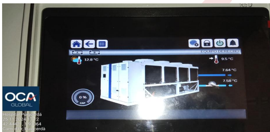
Panta de control de las unidades de clima
