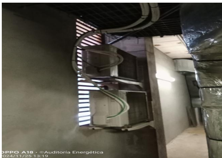
Unidad Exterior - bomba de calor para sistema Split
