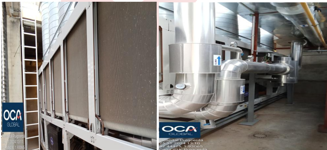
Unidad Exterior-enfriadora-condensadora por aire Carrier 30KAV, (con compresor de tornillo)
