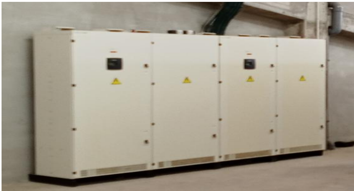
Equipo doble de Condensadores
